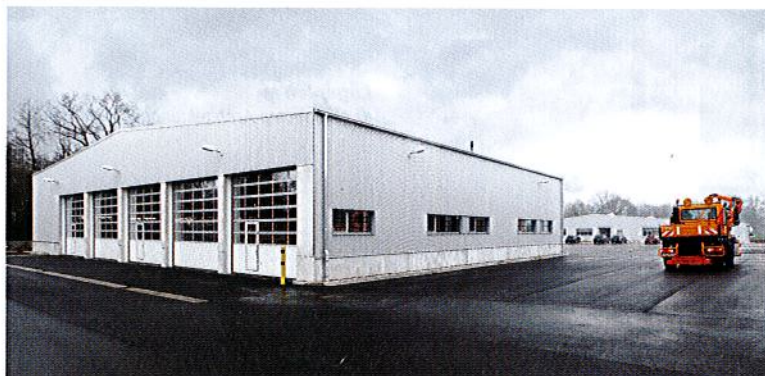
Funktionsbauwerk mit Trapezblechverkleidung © Sebastian Grundgeir
